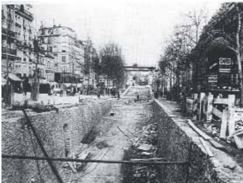
Percement de la ligne 2 à sa sortie de terre sur le boulevard de Rochechouart.
