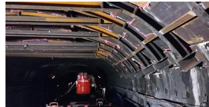
Platelage métallique en tunnel
